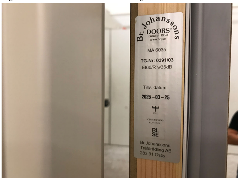
Figur 4. Dörrbladets insida och märkning, MA 6035.
