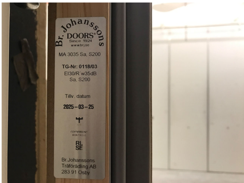
Figur 3. Dörrbladets insida och märkning, MA 3035.
