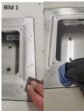
Bild 1 Slipa ramen med ett fint slippapper. Tvätta med T-Röd eller motsvarande. Låt torka.
