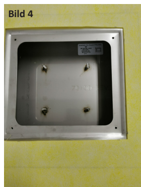
Bild 4 Innan folien appliceras ska den anpassas så att håltagningen B: 220 mm x H: 200 mm för boxen kommer i centrum på våden
