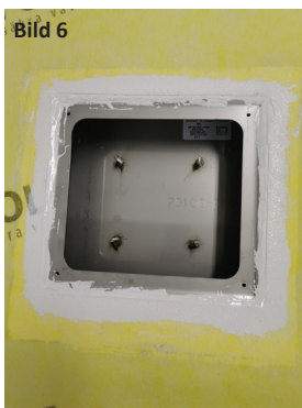
Bild 6 Försegla skarven mellan folien och Box300 ut på ramen med LIP Skarvlim MSP.
