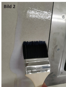
Bild 2 Prima underlaget med LIP Primer 54. Låt torka normalt ca 1 timme.
