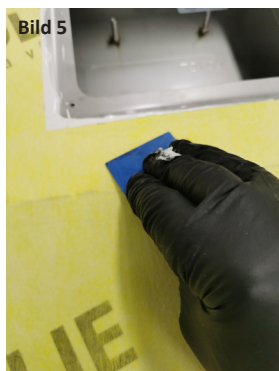
Bild 5 Applicera folievåden på väggen, centrerad över Box300 i det fuktiga Folielimmet och det fuktiga Skarvlimmet på Box300, arbeta bort veck, luftblåsor och överflödigt lim med foliespackel eller plastspackel.
