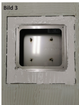
Bild 3 Applicera Folielimmet med Folielimspackel eller rulle för drygt en våd i taget på väggen. Applicera LIP Skarvlim MSP på ramen med en patronspruta och en limspridare
