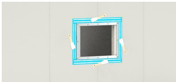
2. Sprid ut limmet med fintandad limspredare / Spackelspade.
