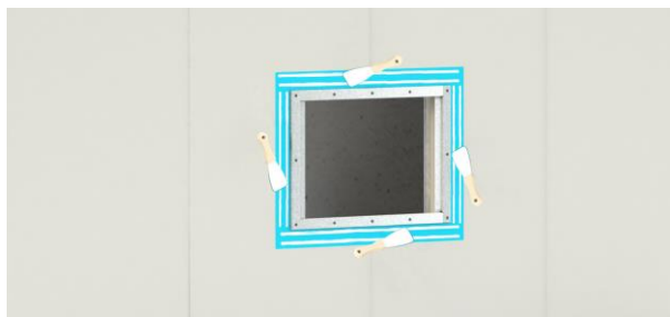
2. Sprid ut limmet med fintandad limsridare / Spackelspade.
