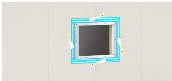
2. Sprid ut limmet med fintandad limspredare / Spackelspade.
