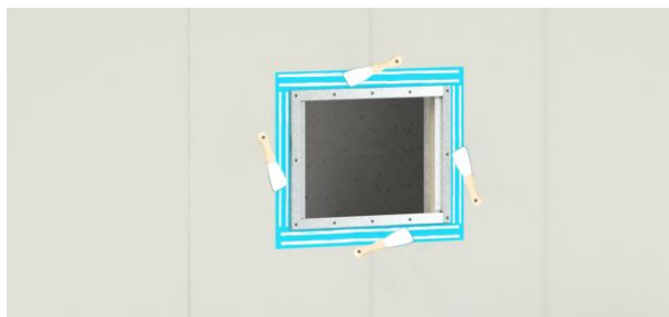
2. Sprid ut limmet med fintandad limspredare / Spackelspade.
