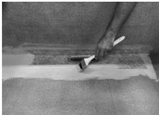
8. Applicera LIP Skarvlim MSP på manschetten och LIP 2K Folielim på övrig golv och väggyta. Montera LIP väggfolie och överlappa manschetten med minimum 5 cm.
