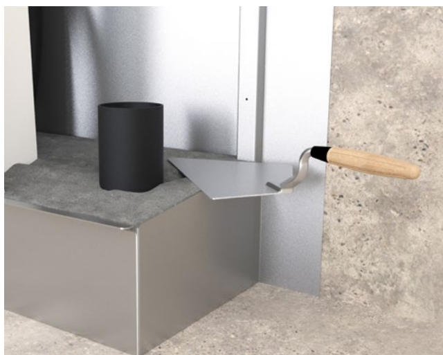
Schaktbotten formas med fall.
