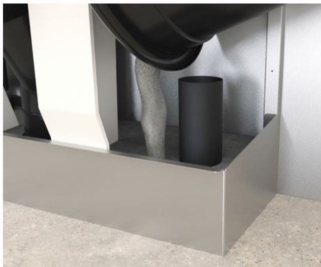
Schaktbotten och eventuell håltagning gjuts igen.
