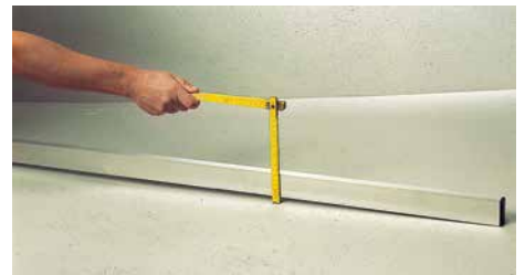
Kontrollera att inga svackor eller bulor förekommer innan tätskiktsduken appliceras.
