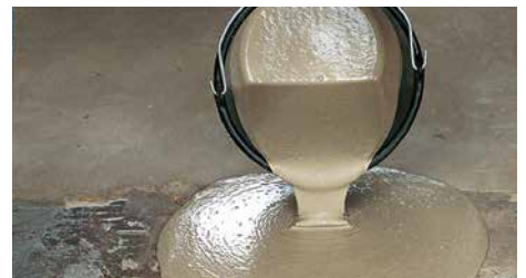
Avjämning utförs med Sopro VS 582.
