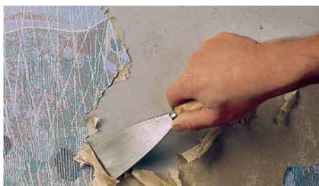
Befintliga ytskikt skall avlägsnas.
