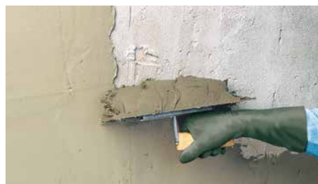
Underlaget förbehandlas med Sopro GD 749 och ojämnheter spacklas ut med Sopro RAM 3 454 eller Sopro USW 941.
