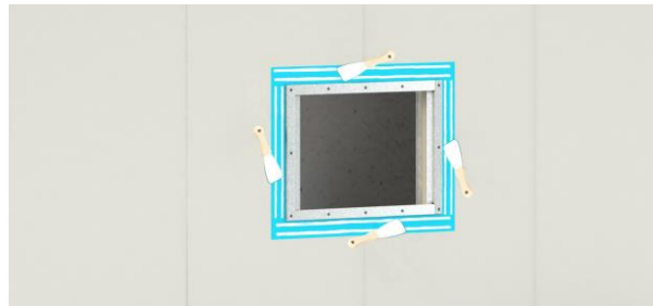
2. Sprid ut limmet med fintandad limspredare / Spackelspade.
