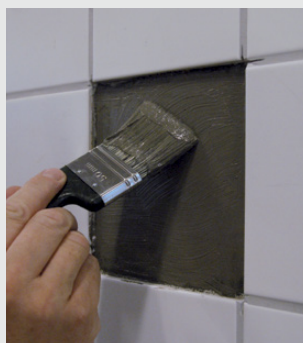
Tätningsmassan påförs underlaget och plattan monteras
