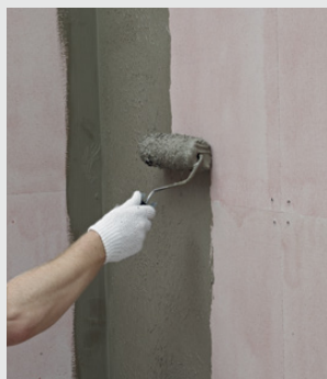
Påföring av tätningsmassa
