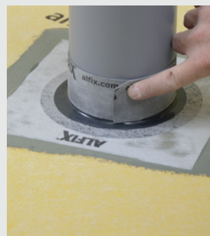
Förstärkning med Seal-Strip vid vattenbelastade rör
