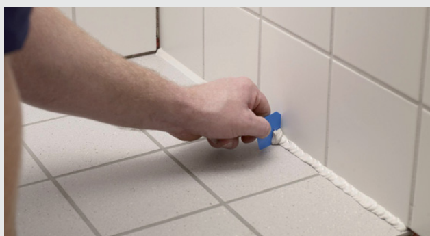
Överskjutande Alfix Silicon skrapas bort
