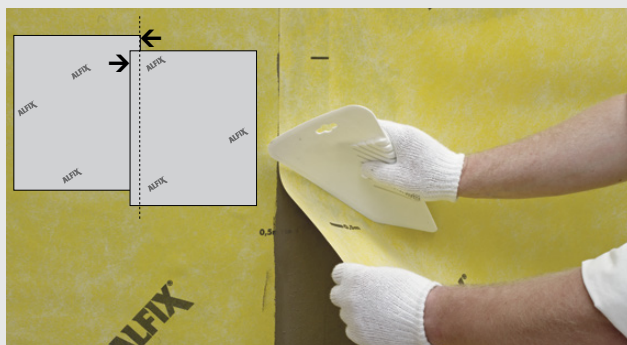
Montering av våd omlott vid skarv
