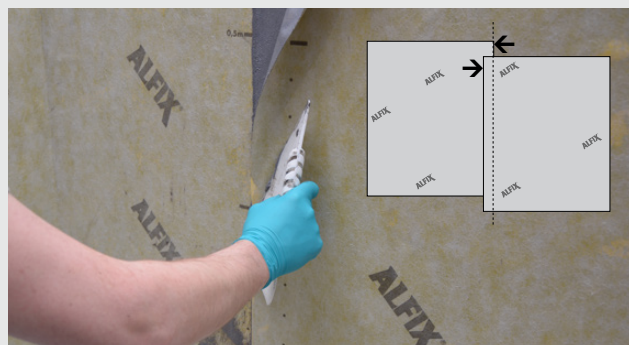
Montering av våd omlott vid skarv
