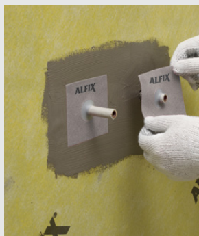
Montering av VT-Rörmanschetter
