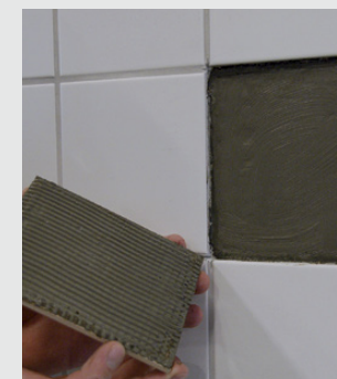
Tätningsmassan påförs underlaget och plattan monteras
