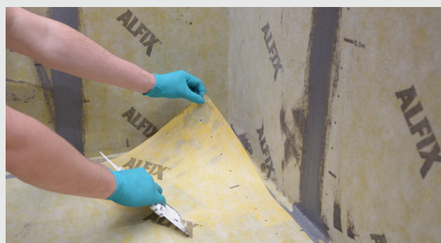
Montering av våtrumsmatta på golv
