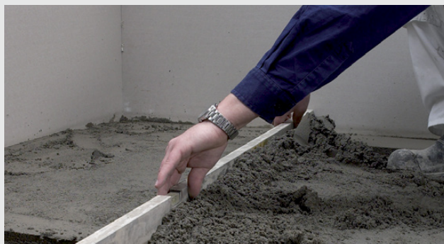
Gjutning på träbjälklag
