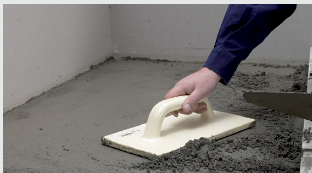
Slättbehandling med rivbräda
