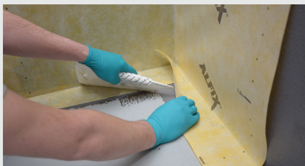
Montering av våtrumsmattan
