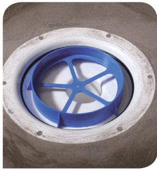
JAFO – Montera JAFO Skärmall med skärmallens taggar i skruvhålen för klämringen.
