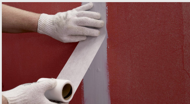
Skivskarvar förseglas med Armeringsremsa monterad i 1K eller 2K Tätningsmassa
