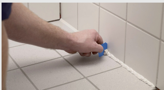
Överskjutande fogmassa skrapas bort
