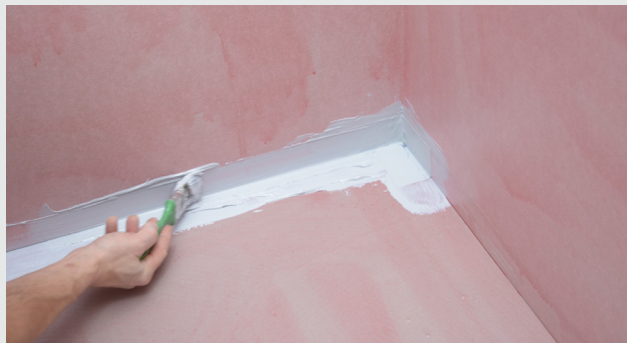
Montering av Armeringsremsa i tätningsmassa
