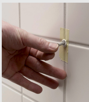
Montering av plastplugg och montering av skruven efter fyllning med M-Silicon
