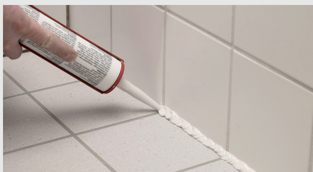
Påföring av M-Silicon så att hela fogen fylls
