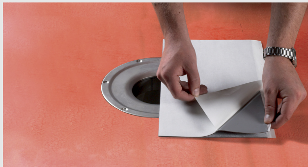
Montering av brunnsmanschett vid rund golvbrunn
