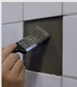
Tätningsmassan påförs underlaget och plattan monteras
