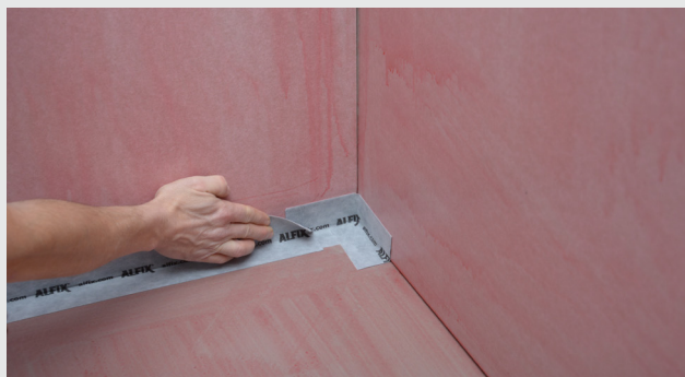
Montering av Seal-Strip, självhäftande
