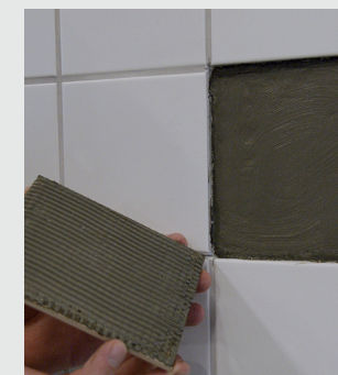
Tätningsmassan påförs underlaget och plattan monteras
