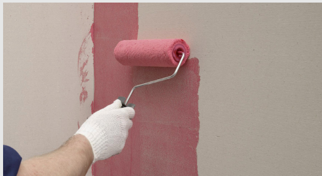
Påföring av Alfix Vattenspärr på vägg med roller
