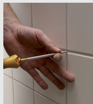
Montering av plastplugg och montering av skruven efter fyllning med M-Silicon
